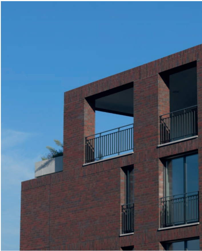
Eine saubere und technisch einwandfreie Lösung: Attika-Element als Ziegel-Fertigteil...
