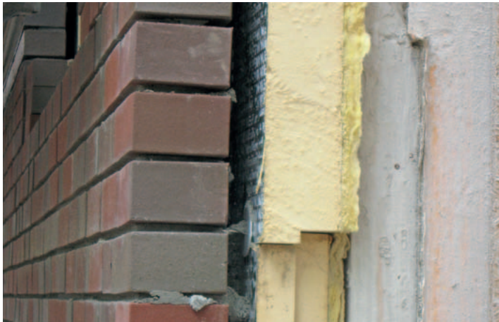
Oben: Abriss der alten Verblendschale - das sogenannte Stripping.
